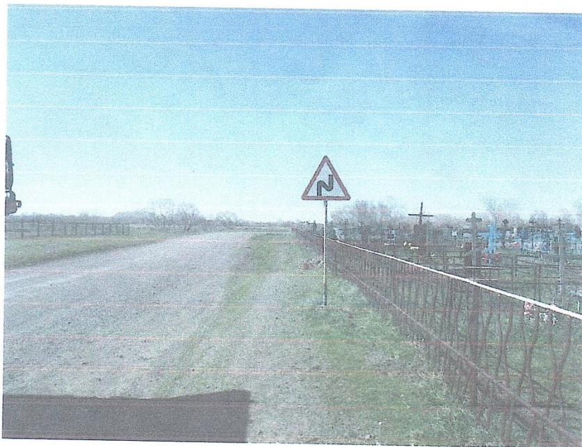
Опасный поворот. Между с. Черкассы и с. Александровка
